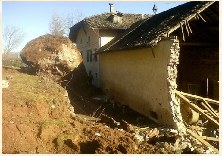
Una roca de unos 600 metros cúbicos se detuvo a un metro de la casa, en la cual se encontraba la familia que vive
